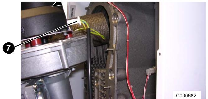
►Die Baugruppe Reinigungsklappe, Gebläse, Brenner und Gasarmatur abnehmen.
